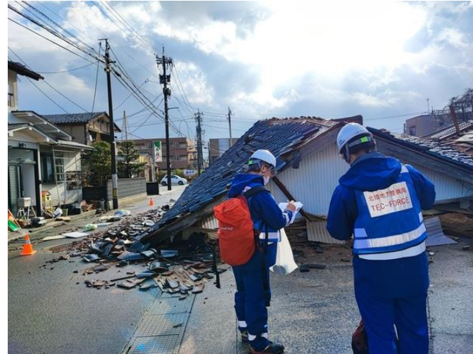
石川県穴水町川島
