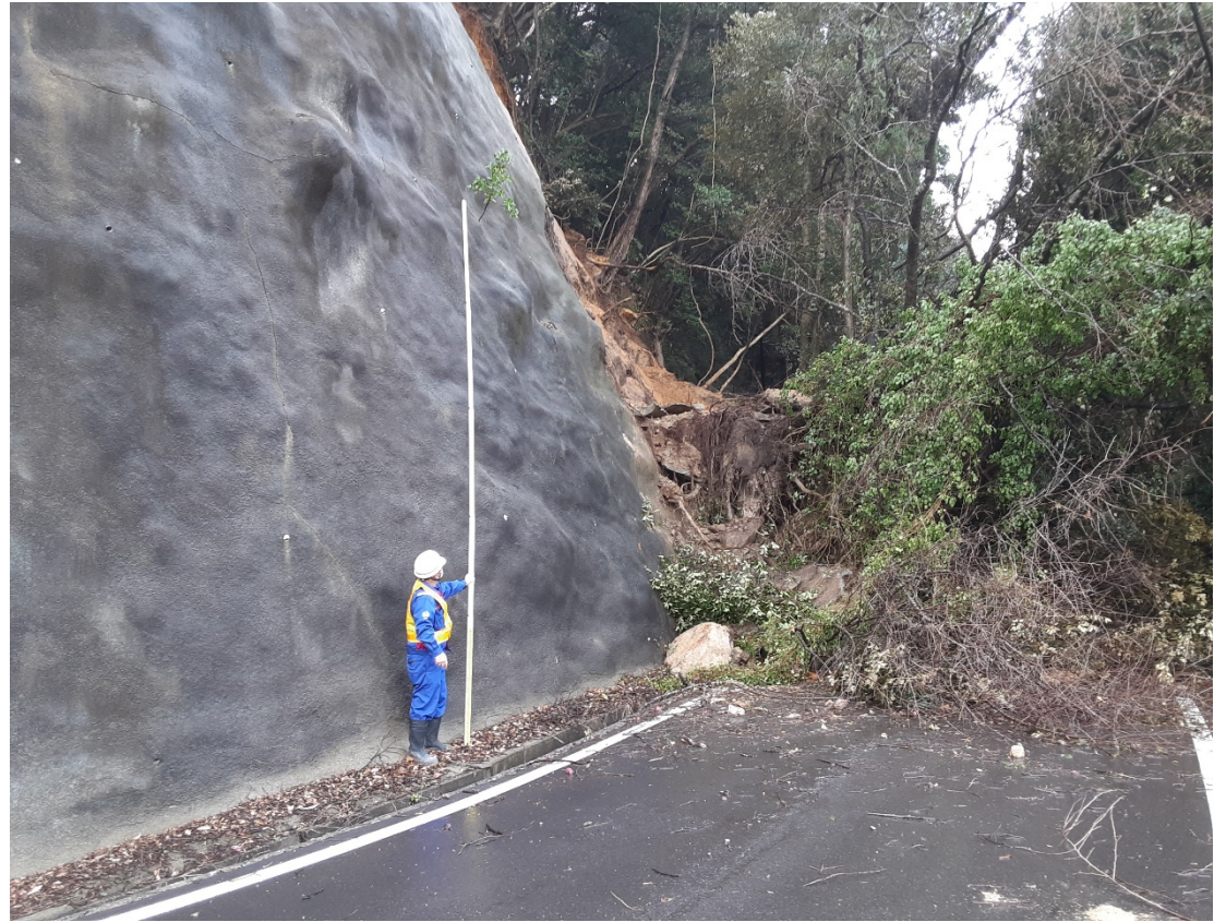
○道路班による現地調査 (七尾市内)
