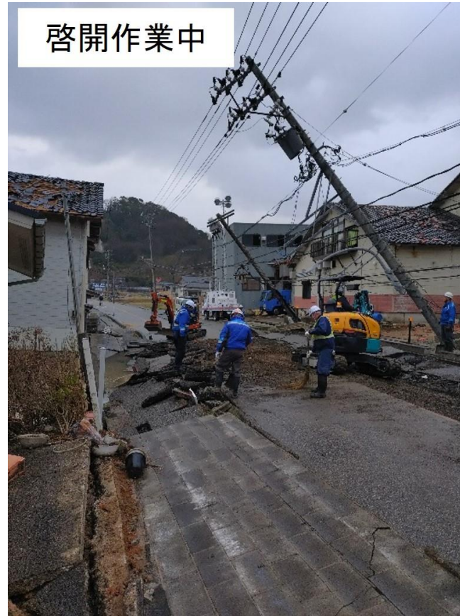
国道249号輪島市稲船町付近
