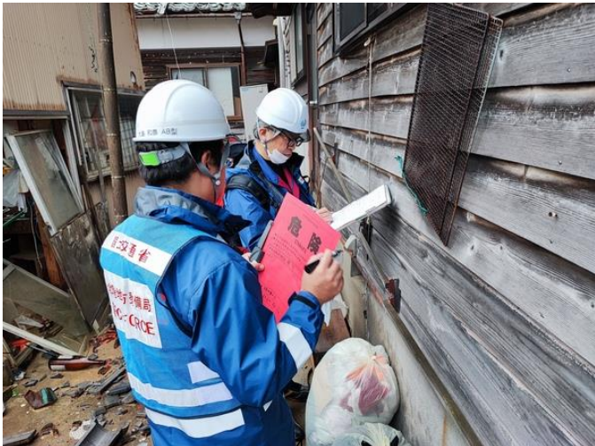
石川県穴水町川島
