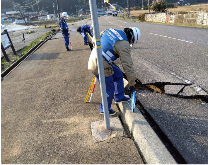
○道路班による現地調査 (七尾市内)
