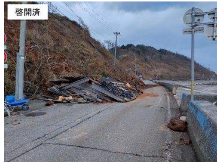
国道249輪島市里町付近
