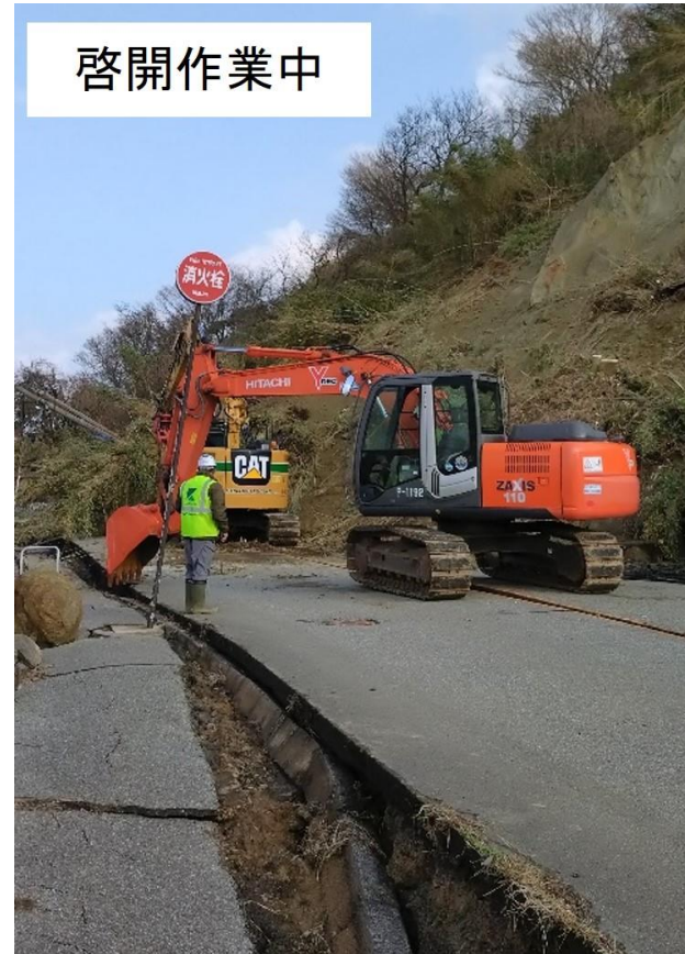
国道249号輪島市稲船町付近
