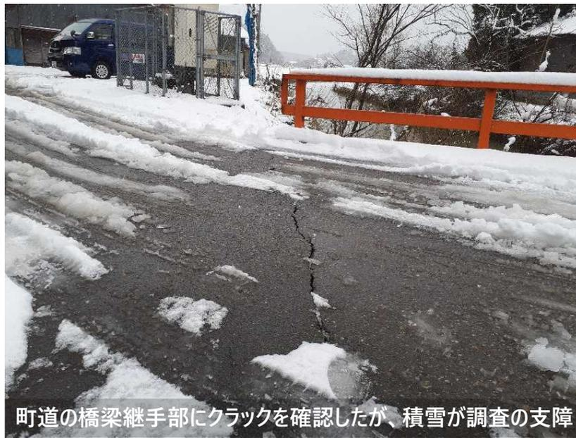
町道の橋梁継手部にクラックを確認したが、積雪が調査の支障
