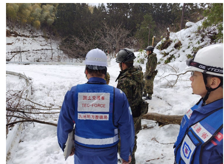
△現地調査の状況（輪島市上山町）
