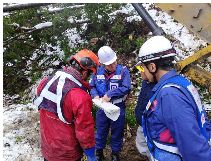
△現地調査の状況（輪島市上山町）
