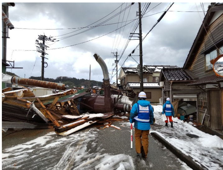
△現地調査の状況（輪島市鳳至町）
