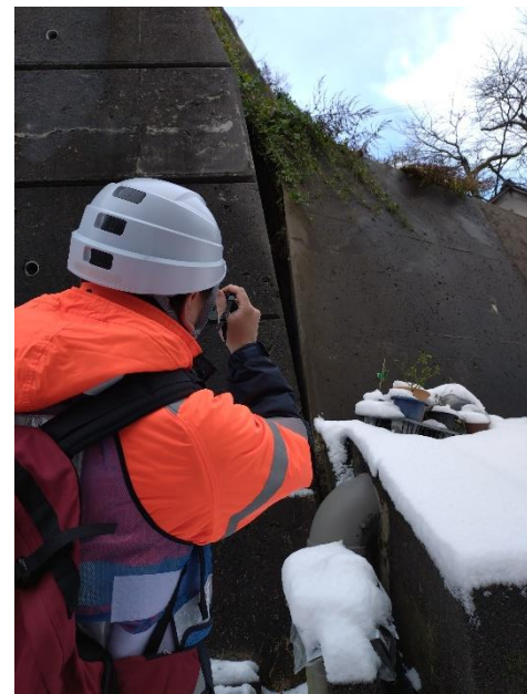
施設調査状況 (能登町宇出津地先)
