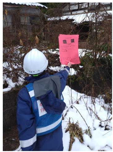
応急危険度判定の様子③ (石川県穴水町)
