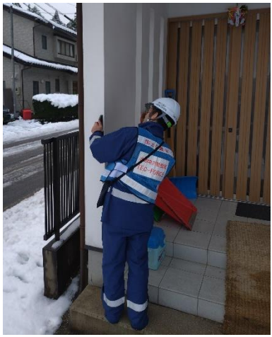
応急危険度判定の様子② (石川県穴水町)
