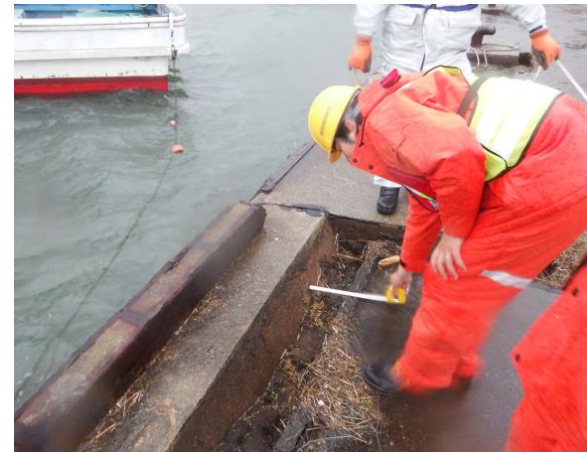
七尾港 被災状況調査
