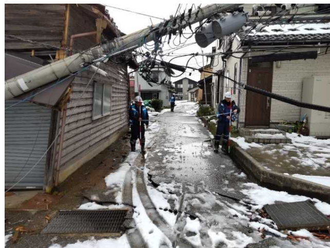
【市町道調査班】珠洲市 作業状況（9日）
