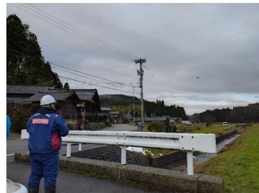
第3班 志賀町 ドローンを活用した被災状況調査
