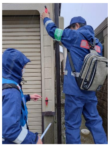
応急危険度判定の様子③ (新潟県新潟市)
