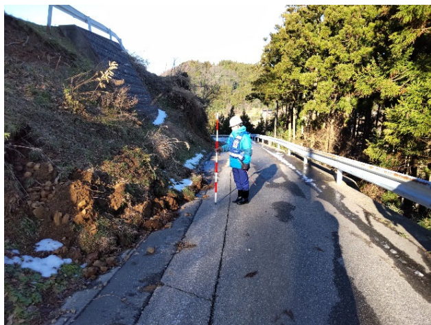
△ 現地調査の状況（輪島市）
