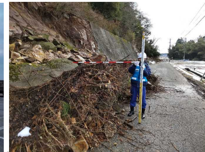
【市町道調査班】珠州市 作業状況(11日)
