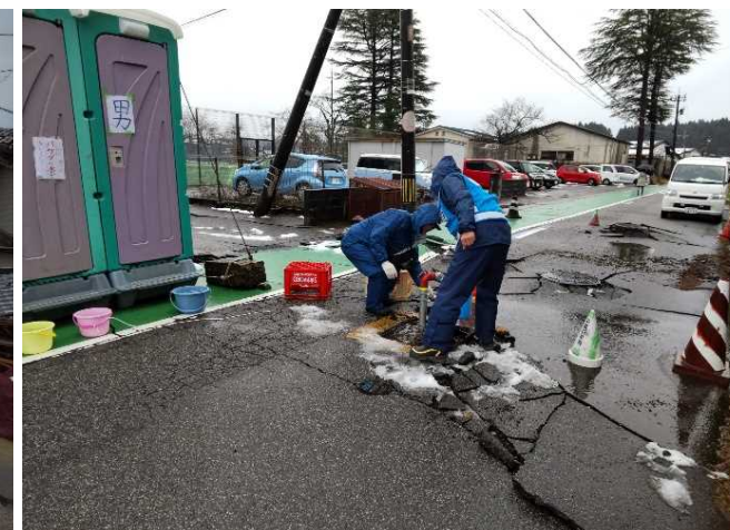
【高度技術指導班(水道)】穴水町 漏水確認作業状況(10日)
