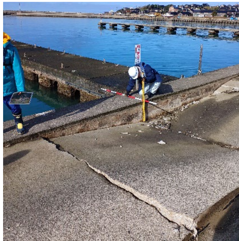
港湾班による滝港(羽咋市)に おける被害状況調査
