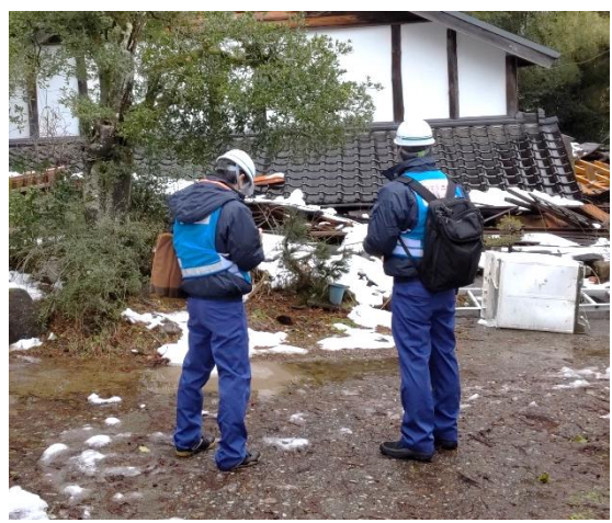
応急危険度判定の様子② (石川県珠洲市)
