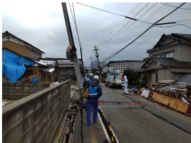
【営繕支援班】珠州市 応急危険度判定作業状況(10日)
