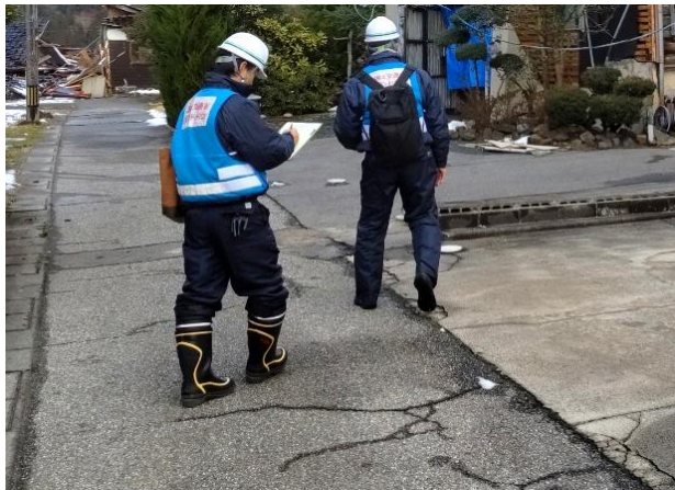
応急危険度判定の様子② (石川県珠洲市)
