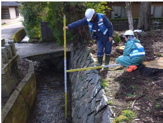
第3班 志賀町護岸被災状況調査
