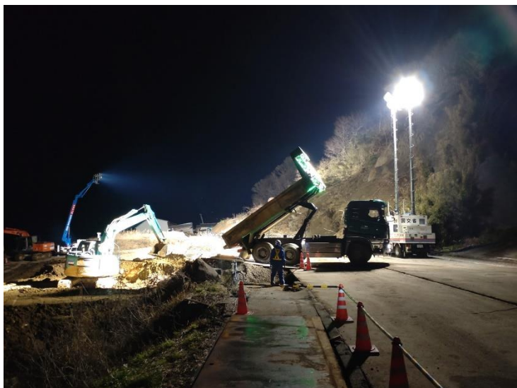
照明車による活動状況(輪島市内)
