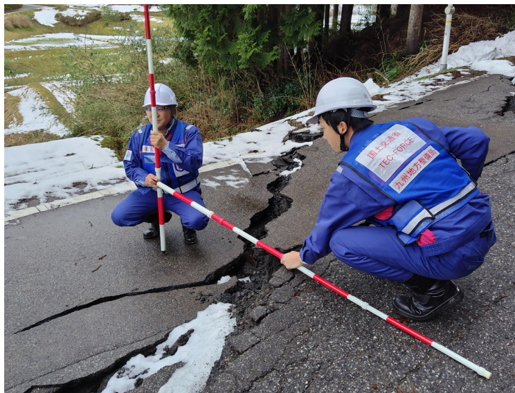
△ 現地調査の状況（輪島市）
