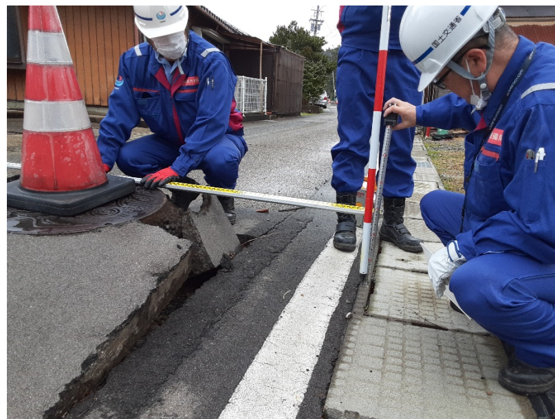
道路班による現地調査(七尾市)
