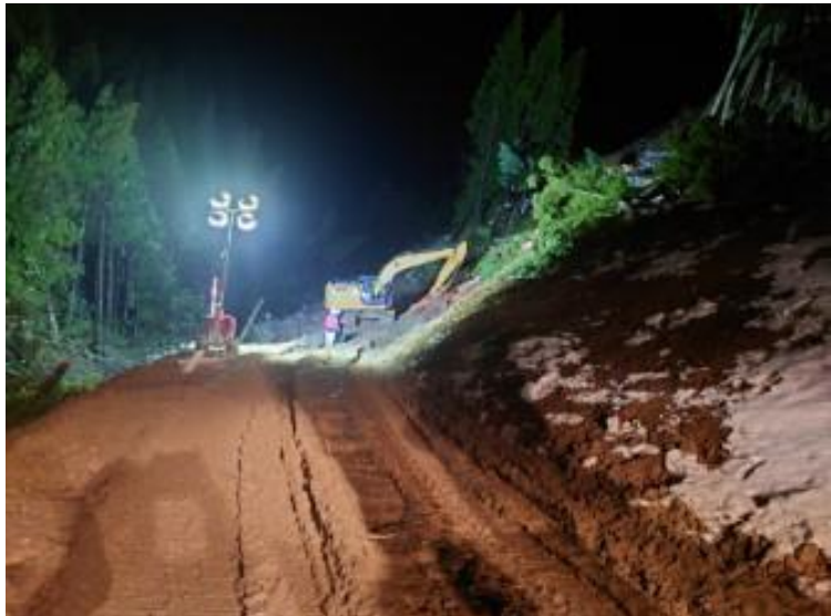
照明車による活動状況(輪島市内)
