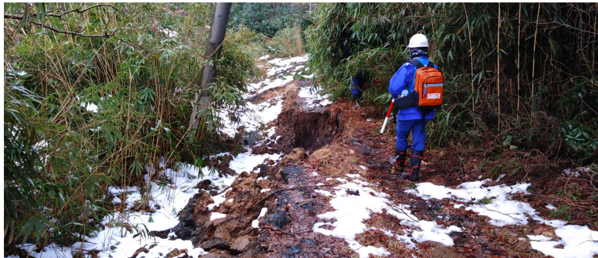
△ 現地調査の状況（輪島市町野町）
