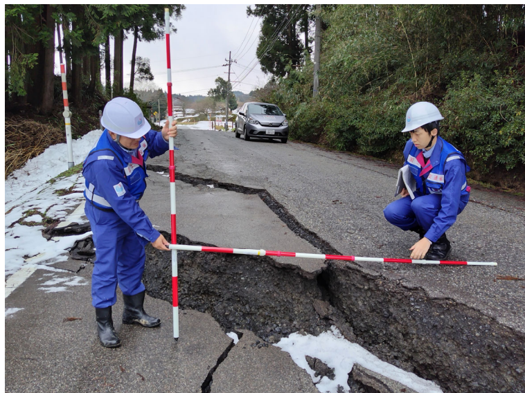
△ 現地調査の状況（輪島市）
