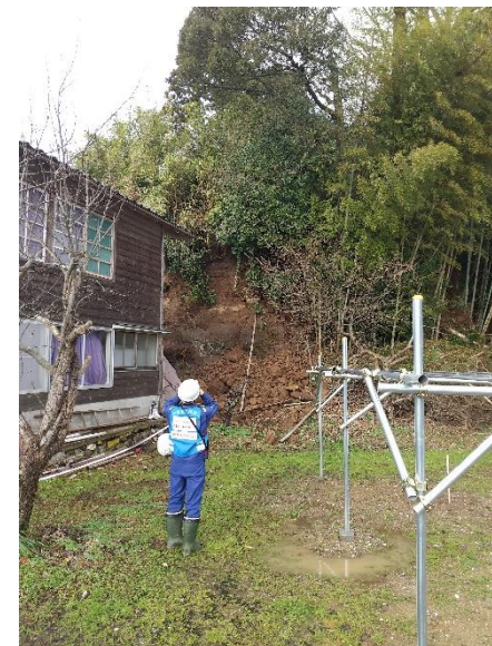
被害状況調査(石川県穴水町字麦ヶ浦)
