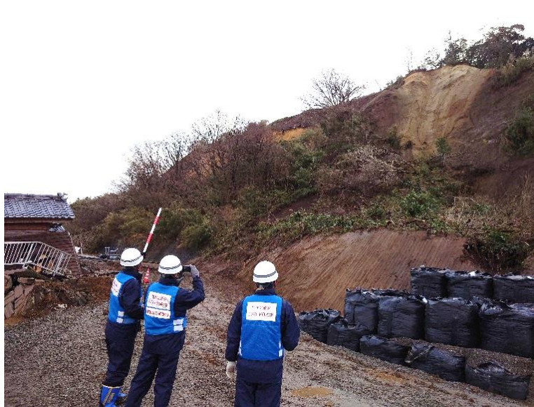
被害状況調査(石川県輪島市大野町)
