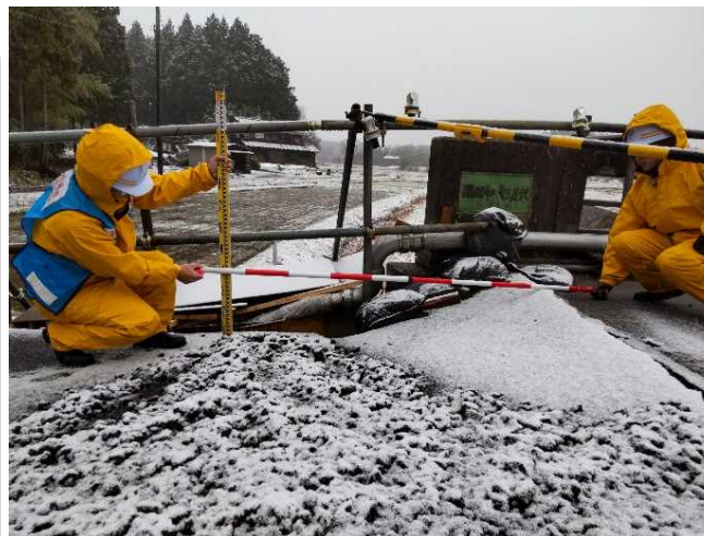
【市町道調査班】 珠洲市 作業状況（13日）
