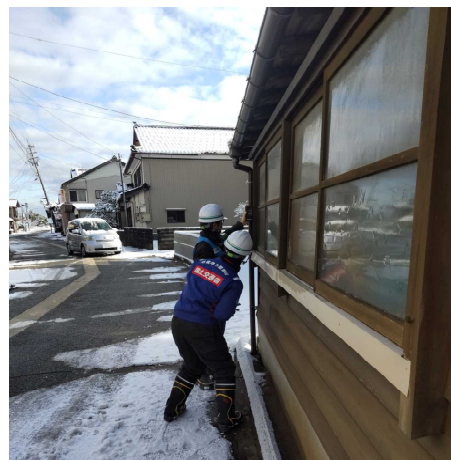
【営繕班】能登町 作業状況（14日）
