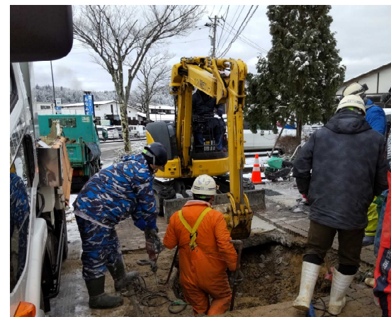
【水道班】穴水町 作業状況（14日）
