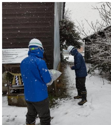
応急危険度判定の様子② (石川県珠洲市)
