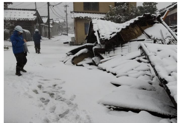
応急危険度判定の様子③ (石川県珠洲市)
