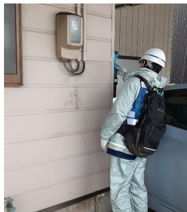
応急危険度判定の様子① (石川県珠洲市)
