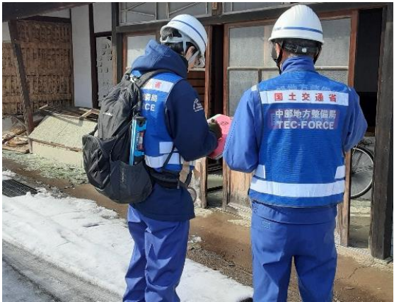
応急危険度判定の様子① (石川県能登町)
