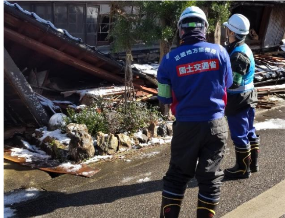
応急危険度判定の様子② (石川県能登町)
