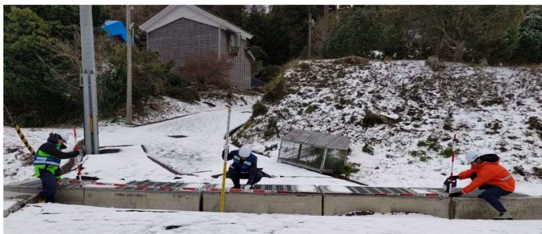
被災状況調査（輪島市 道路班）
