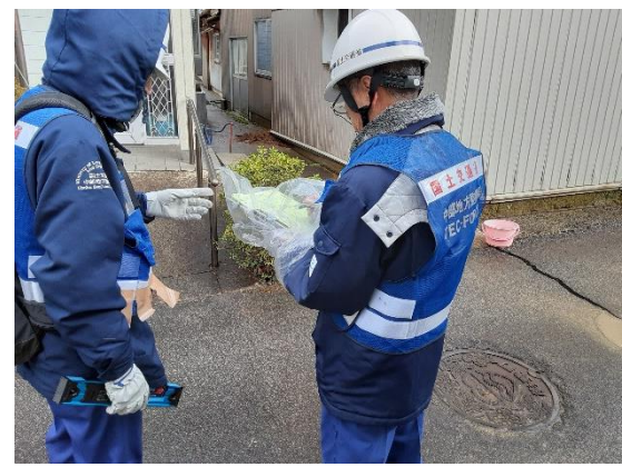
応急危険度判定の様子② (石川県能登町)
