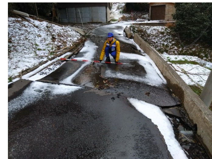
△現地調査の状況（輪島市名舟町）
