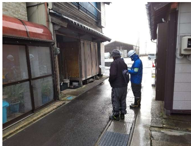
【営繕班】能登町 作業状況（15日）
