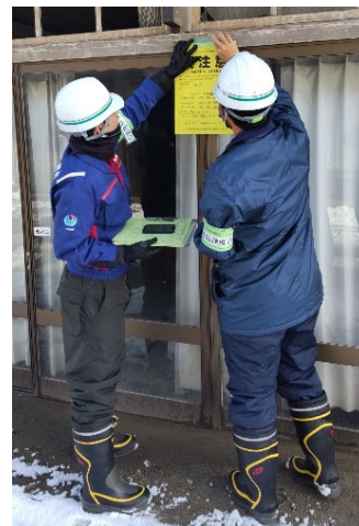
【営繕班】能登町 作業状況（16日）
