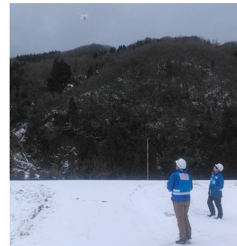
【砂防班】輪島市 作業状況（16日）
