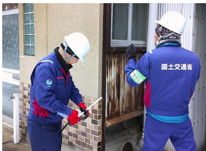
応急危険度判定の様子① (石川県能登町)
