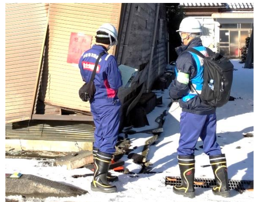
応急危険度判定の様子③ (石川県珠洲市)
