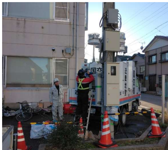
【電源支援班】輪島市 作業状況（17日）
