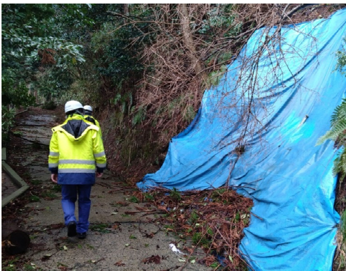
△現地調査の状況（輪島市）
