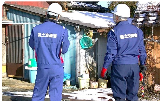
応急危険度判定の様子① (石川県珠洲市)
