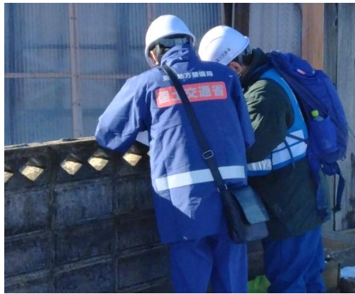
応急危険度判定の様子② (石川県珠洲市)
