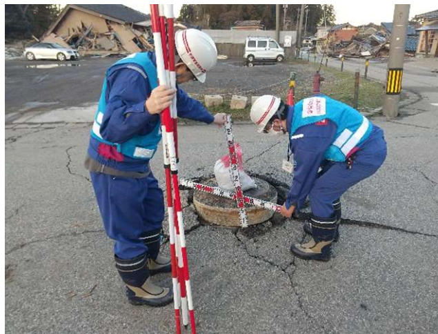
【市町道調査班】珠洲市 作業状況（17日）
