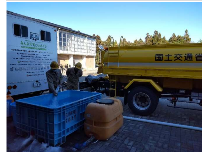
【給水班】能登町 作業状況（17日）
