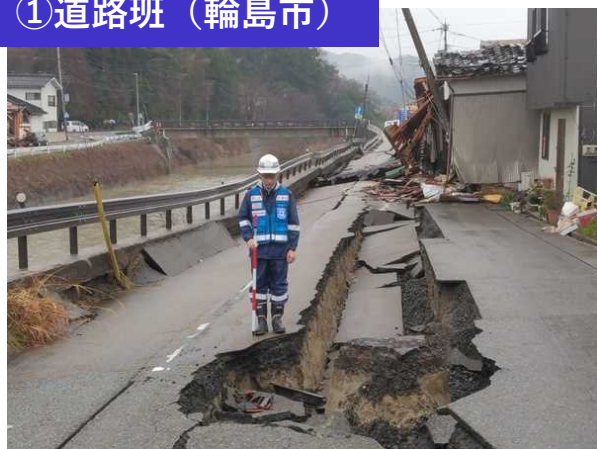
①道路班 (輪島市)
