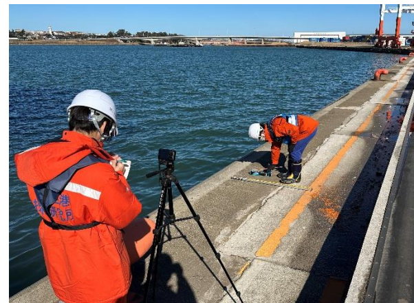
金沢港 被災状況調査
