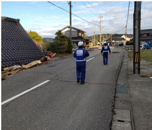
△被災状況調査（輪島市門前町）
