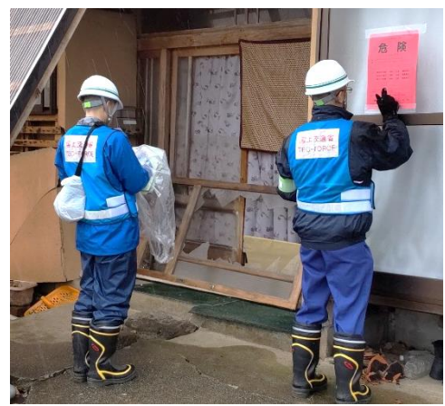
応急危険度判定の様子③ (石川県珠洲市)
