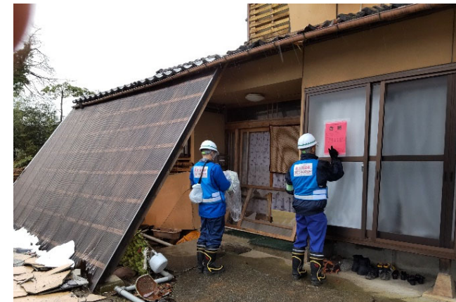
【営繕支援班】珠洲市 作業状況（18日）
