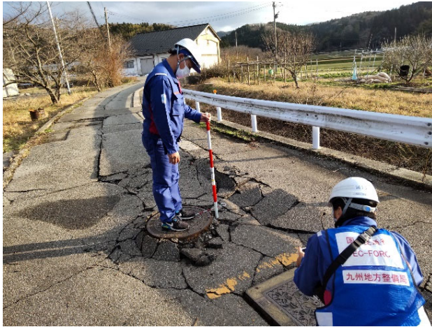
△被災状況調査（輪島市門前町）
