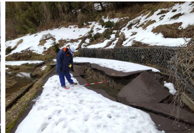
【砂防班】珠洲市 作業状況（19日）
