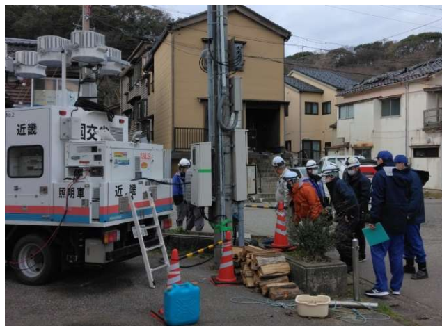
【電源支援班】輪島市他 作業状況（19日）
