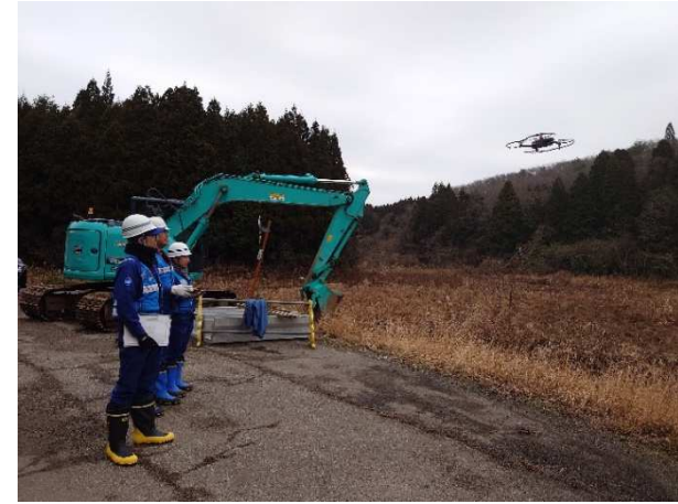
(穴水町内での被災状況調査)
