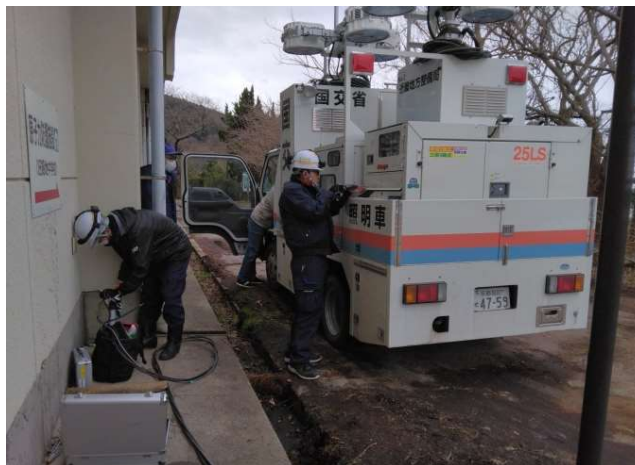
【電源支援班】輪島市他 作業状況（20日）
