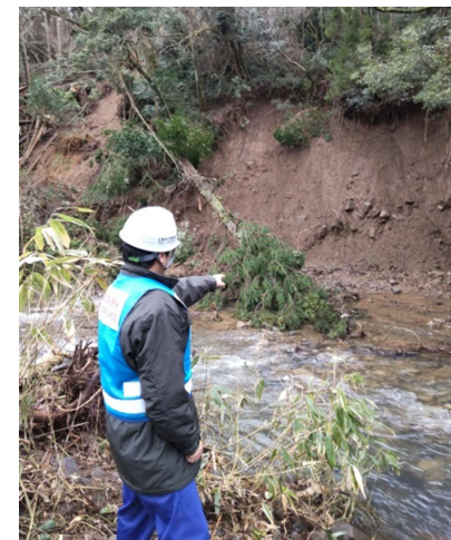
【砂防班】珠洲市 作業状況（20日）
