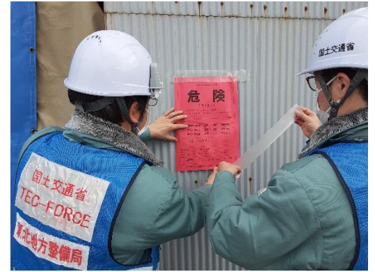
応急危険度判定の様子③ (石川県珠洲市)
