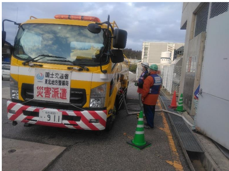
珠洲市総合病院への給水支援状況
