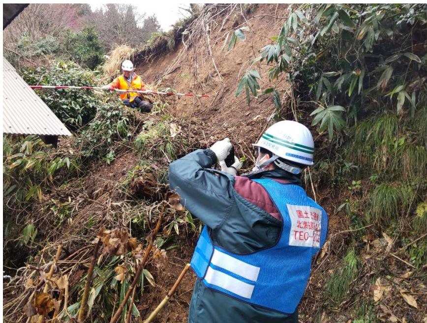
現地調査状況（輪島市門前町西円山）
