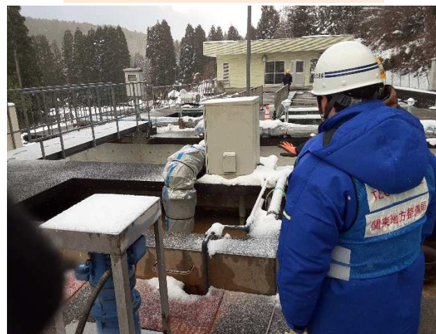
(珠洲市宝立浄水場の復旧状況確認)
