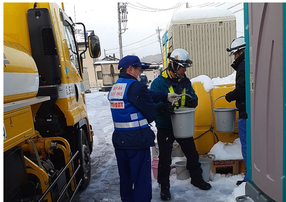
直小学校仮設タンクへの給水支援状況
