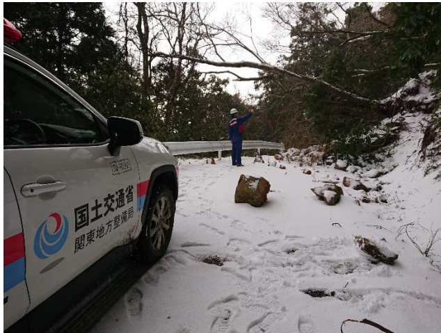
(輪島市内での被災状況調査)
