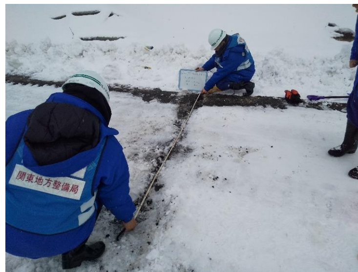
被災状況調査(能登町字柳田)
