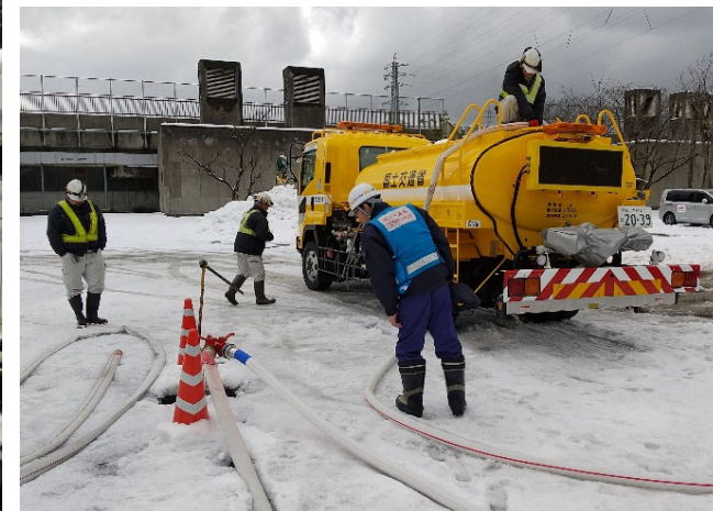
【給水班】金沢市 作業状況（25日）
