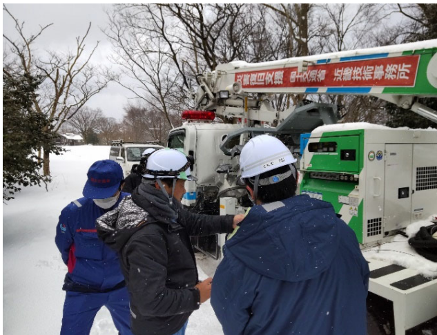
【電源支援班】珠洲市 作業状況（25日）
