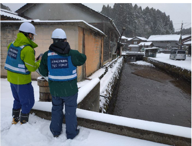
第3班 穴水町 護岸被災状況調査
