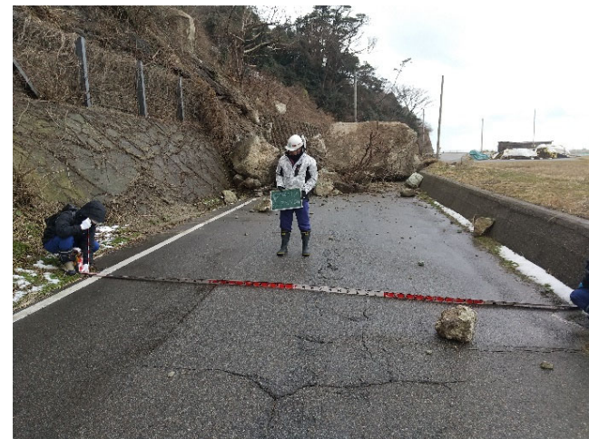
【市町道調査班・砂防班】珠洲市 作業状況（25日）
