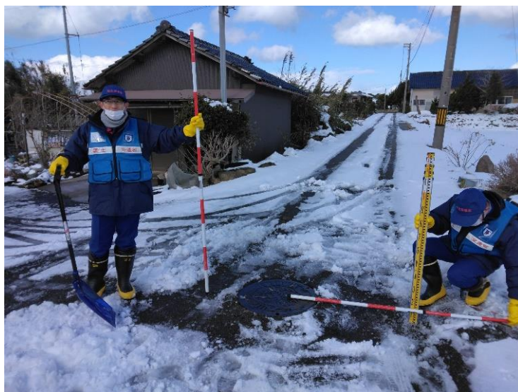
被災状況調査(志賀町百浦)
