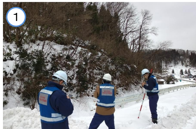
被災状況調査（能登町字上町）
