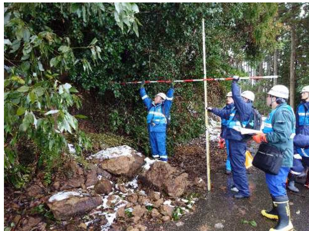
(能登町内での被災状況調査)
