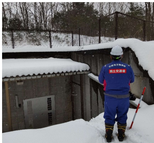
【水道班】穴水町 作業状況(26日)
