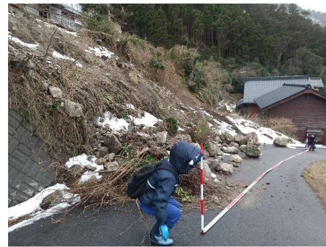
【市町道調査班】珠洲市 作業状況(26日)
