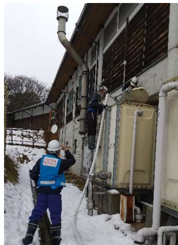
【給水班】能登町 作業状況(26日)
