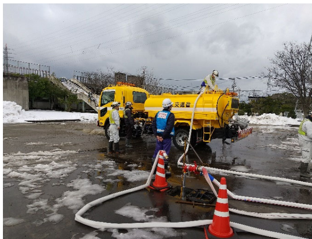
【給水班】金沢市 作業状況（27日）
