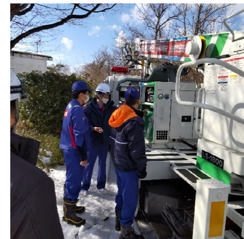
【電源支援班】珠洲市 作業状況（27日）
