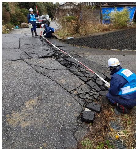
【市町道調査班】珠洲市 作業状況（27日）
