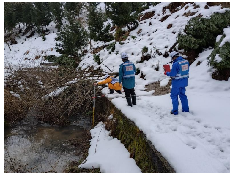
第2班 能登町 被災状況調査
