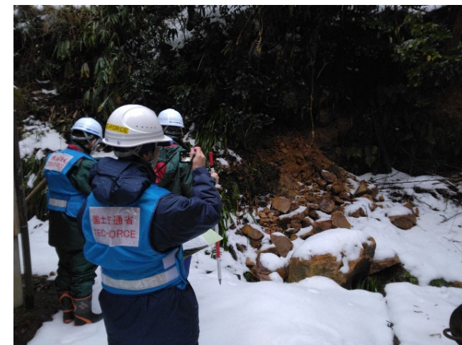
【砂防班】珠洲市 作業状況（27日）
