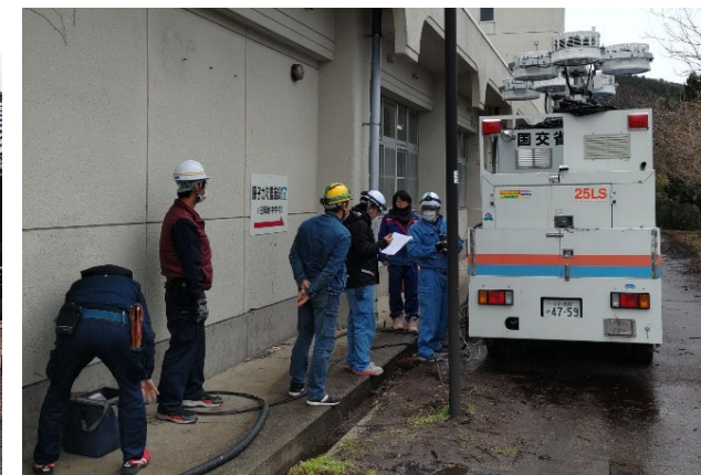
【電源支援班】輪島市 作業状況（28日）
