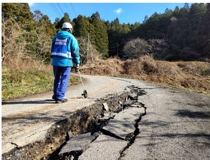
▲現地調査状況 （被災状況調査班（道路））
