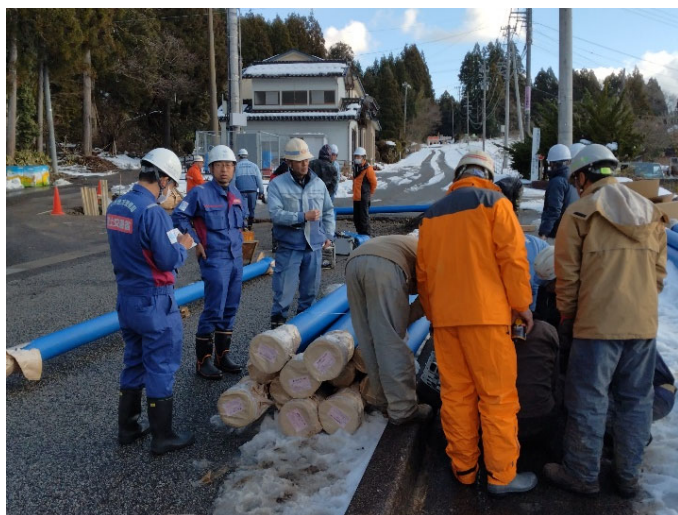
▲現地調査状況 （高度技術指導班（水道））
