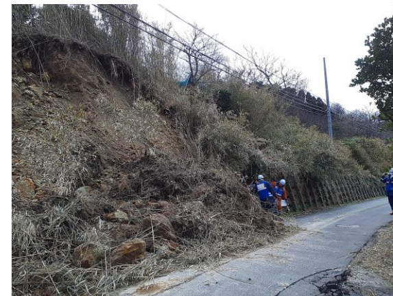
大きく崩壊した法面と擁壁の調査
