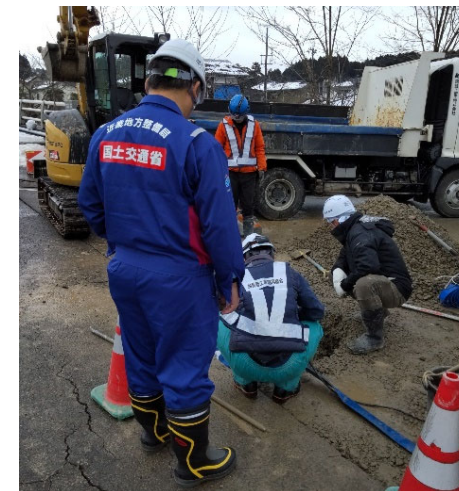
【水道班】穴水町 作業状況（28日）
