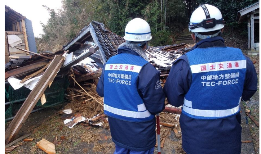
○輪島市二ツ屋町における調査【砂防班】
