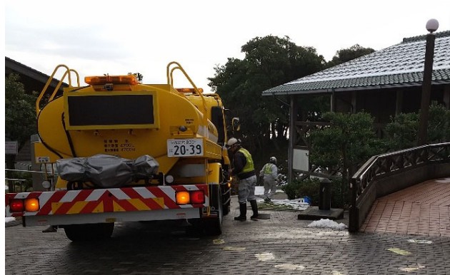
【給水班】能登町 作業状況（28日）
