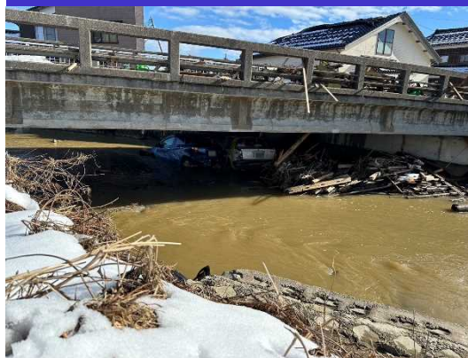
②津波遡上調査状況 (珠洲市)
