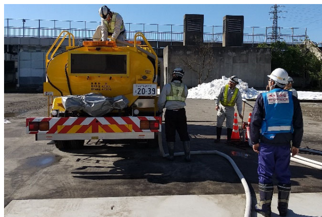
【給水班】金沢市 作業状況（29日）
