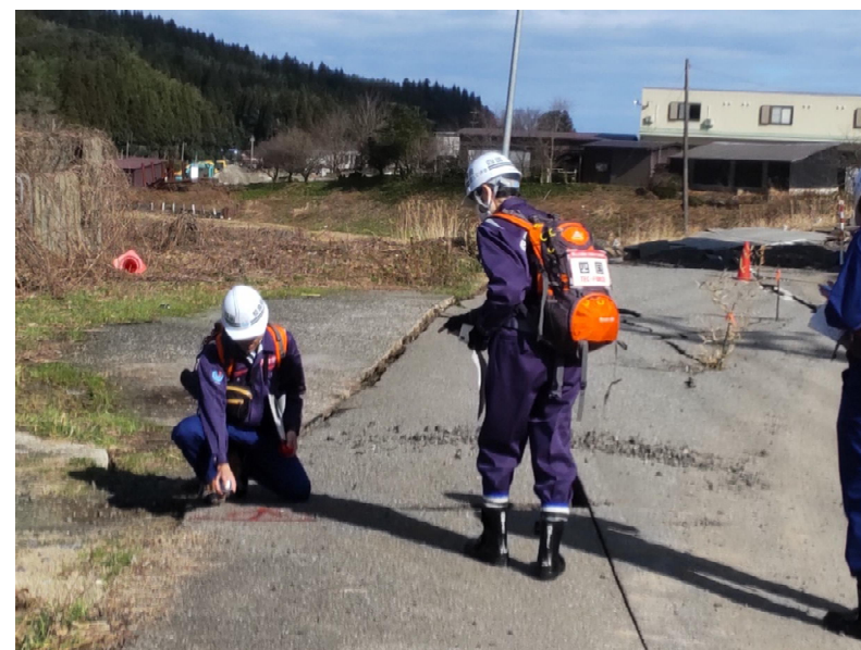
被災状況調査（輪島市小伊勢町）
