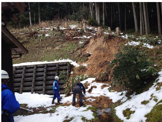
砂防班⑰ 作業状況(輪島市門前町久川)
