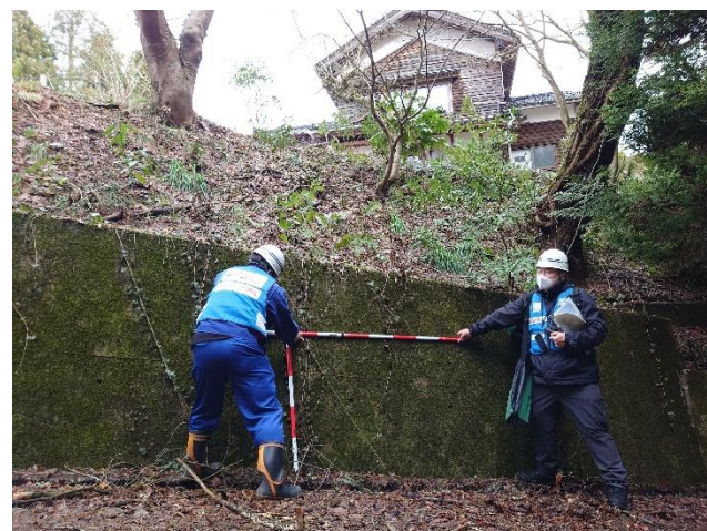
砂防班⑰ 作業状況(輪島市門前町渡瀬)
