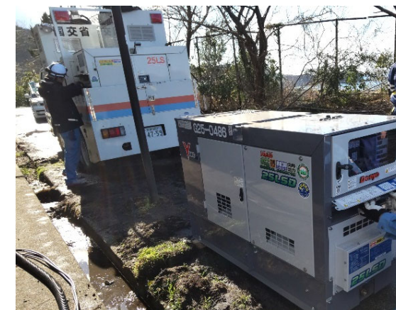
【電源支援班】輪島市 作業状況（29日）
