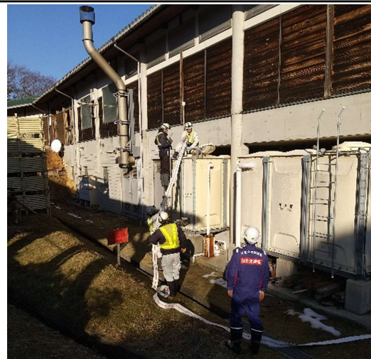
【給水班】能登町 作業状況（30日）
