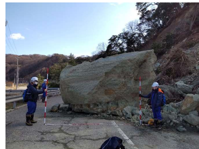
【道路班】珠洲市 作業状況（30日）
