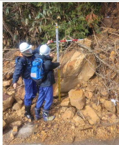
【砂防班】珠洲市 作業状況（30日）
