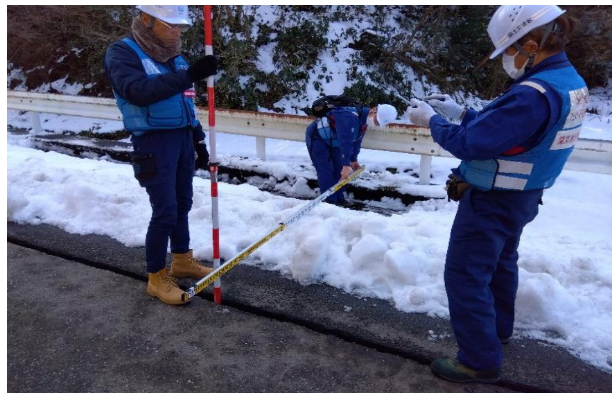
道路班③⑩ 調査状況(能登町字上町)
