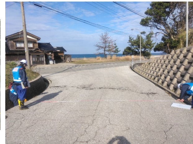
【道路班】珠洲市 作業状況（31日）
