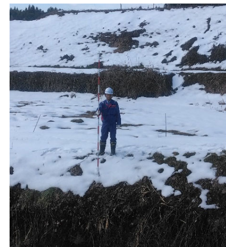
【河川班】輪島市 作業状況（31日）
