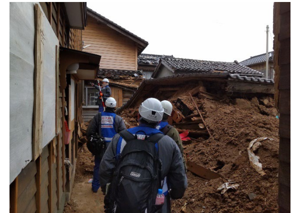
▲現地調査状況 (被災状況調査班 (道路))
