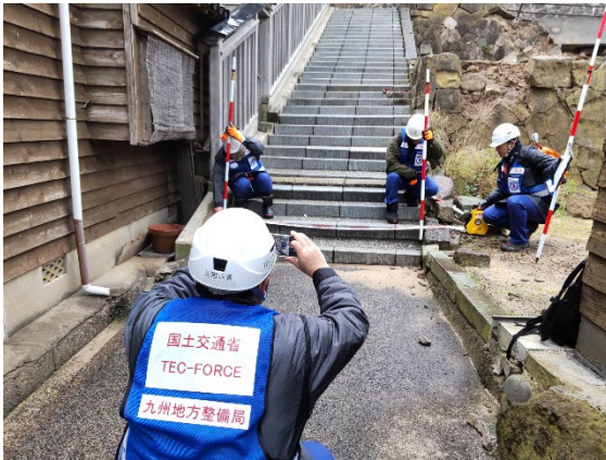
▲現地調査状況 (被災状況調査班 (道路))
