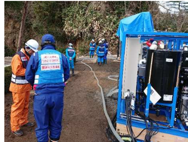
(珠洲市内での給水作業)
