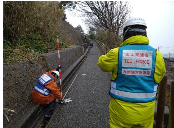
▲現地調査状況 (被災状況調査班 (道路))
