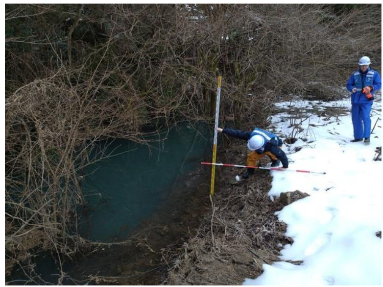
能登町 被災状況調査
