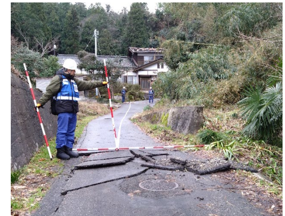
▲現地調査状況 (被災状況調査班 (道路))
