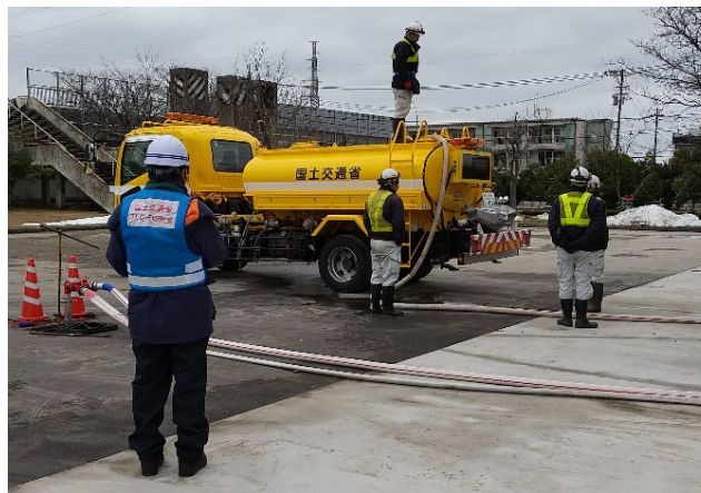
【給水班】金沢市 作業状況（2日）
