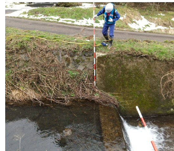
【河川班】輪島市 作業状況（2日）
