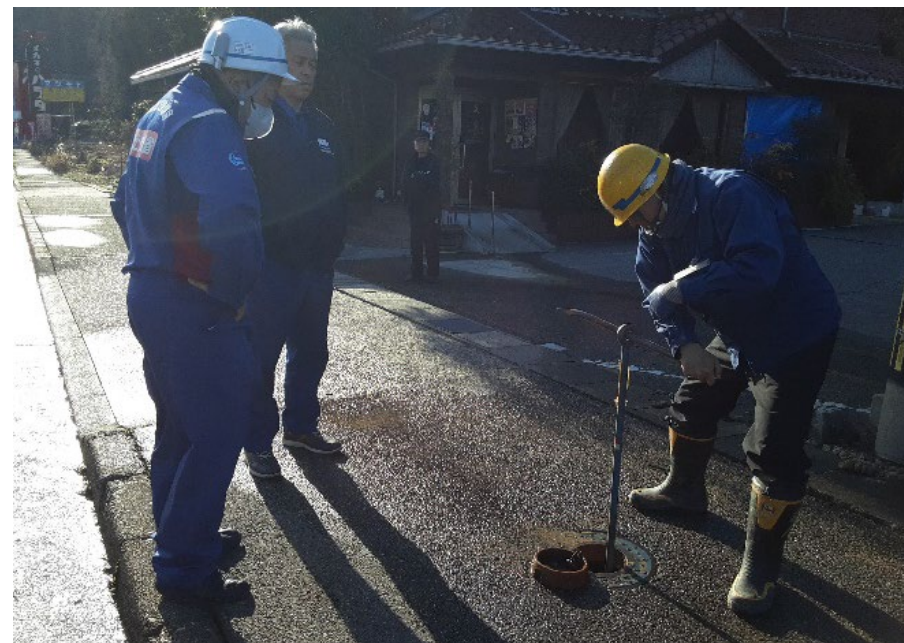
七尾市内にて現地調査【水道支援班】
