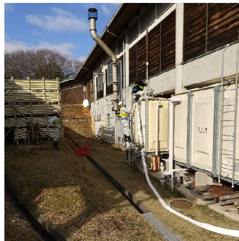
【給水班】能登町 給水状況（3日）
