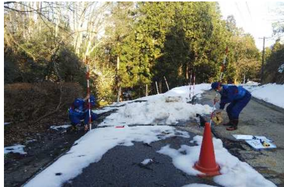
(能登町内での被災状況調査)
