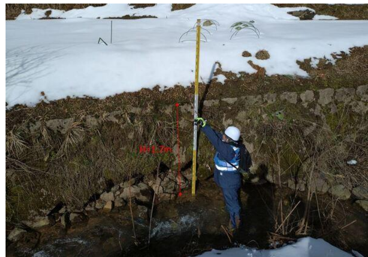
能登町 被災状況調査
