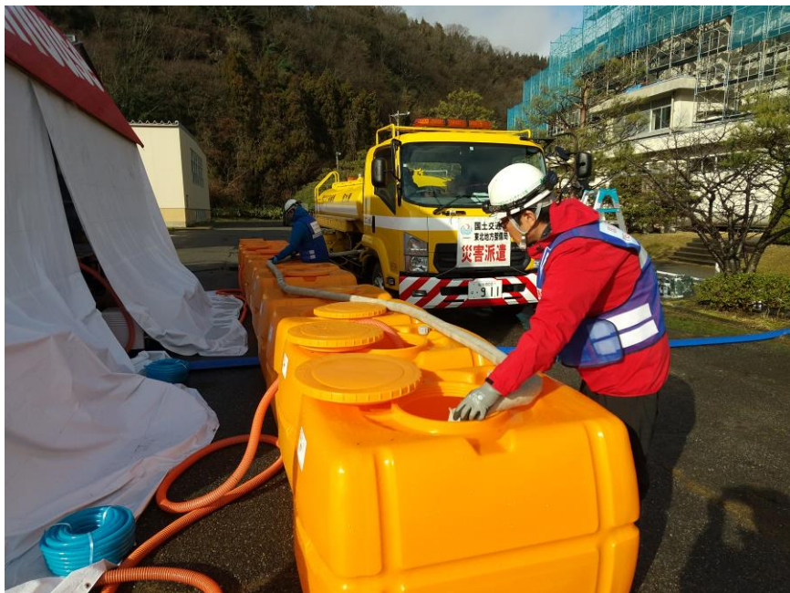
ランドリーカーへの給水支援状況
