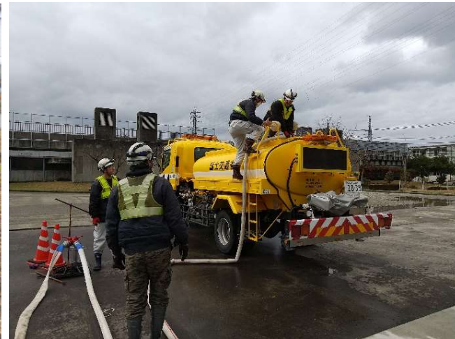
【給水班】金沢市 作業状況（8日）
