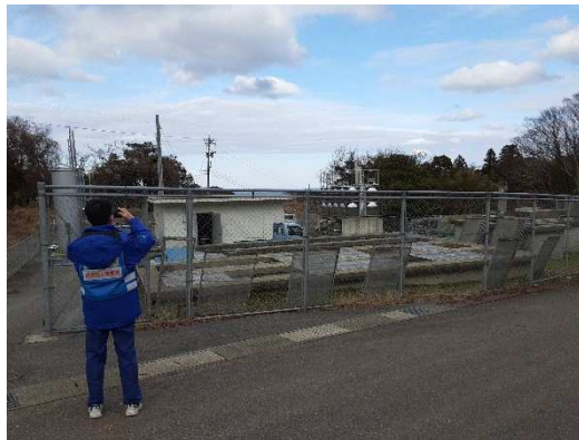
(珠洲市折戸浄水場の現地確認)
