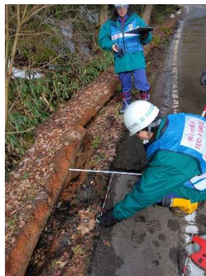
(能登町内での被災状況調査)
