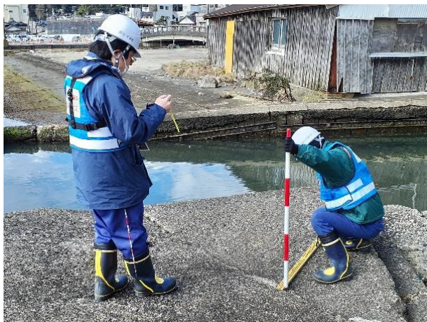
宇出津港における被災状況調査
