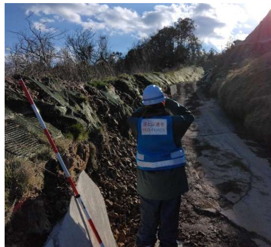
【道路班】輪島市 被災状況調査（11日）
