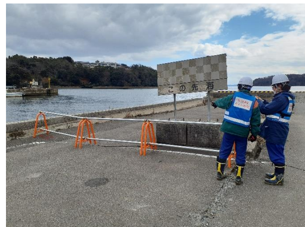
穴水港における被災状況調査
