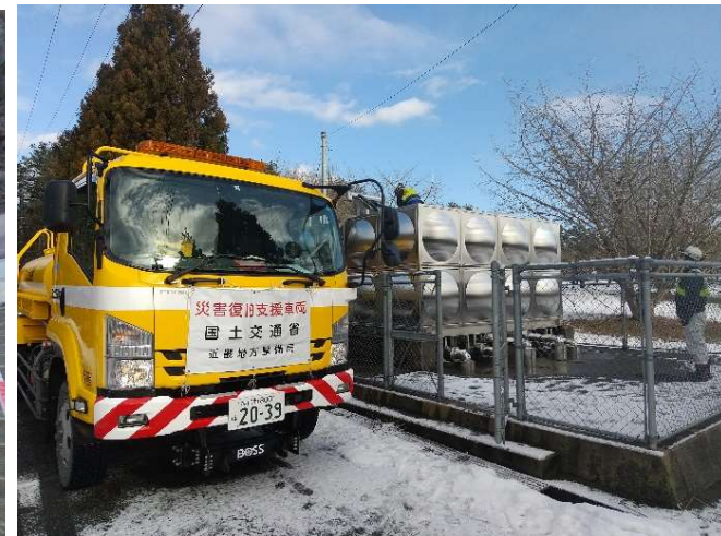
【給水班】能登町 給水状況（11日）
