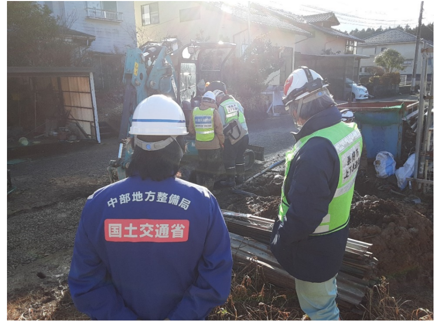
七尾市内にて現地調査【水道班】
