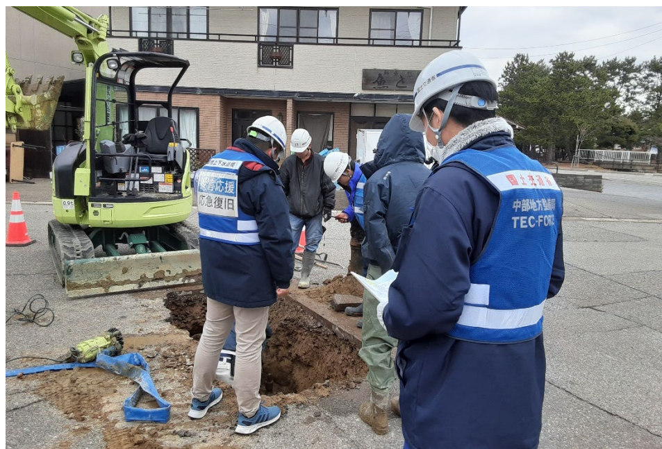
七尾市内にて現地調査【水道支援班】
