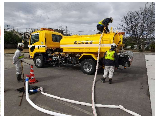
【給水班】金沢市 補水状況（16日）
