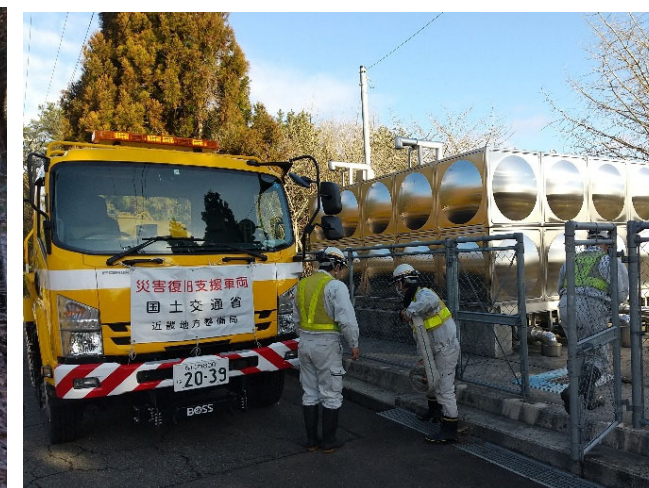
【給水班】能登町 給水状況（17日）
