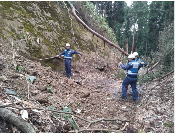
【被害状況調査班】
