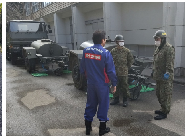
【水道班】穴水町 被災状況調査（17日）
