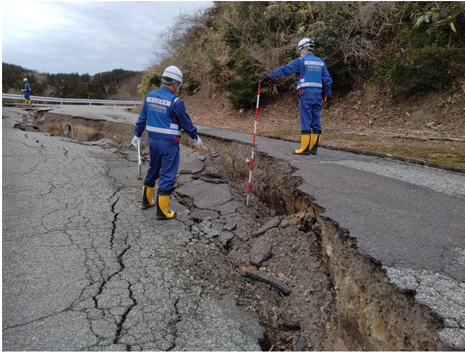
珠洲市内にて現地調査【道路班】
