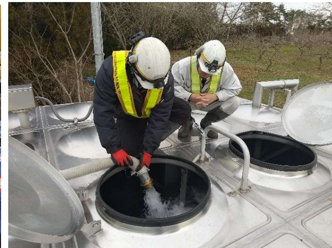
【給水班】能登町 給水状況（19日）
