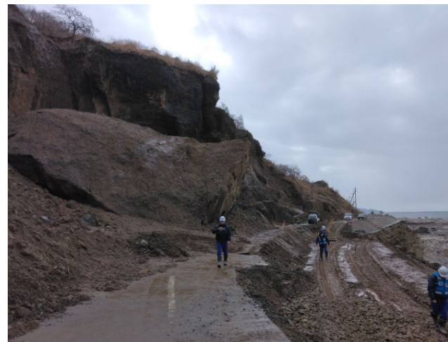
【道路班】輪島市 被災状況調査（23日）
