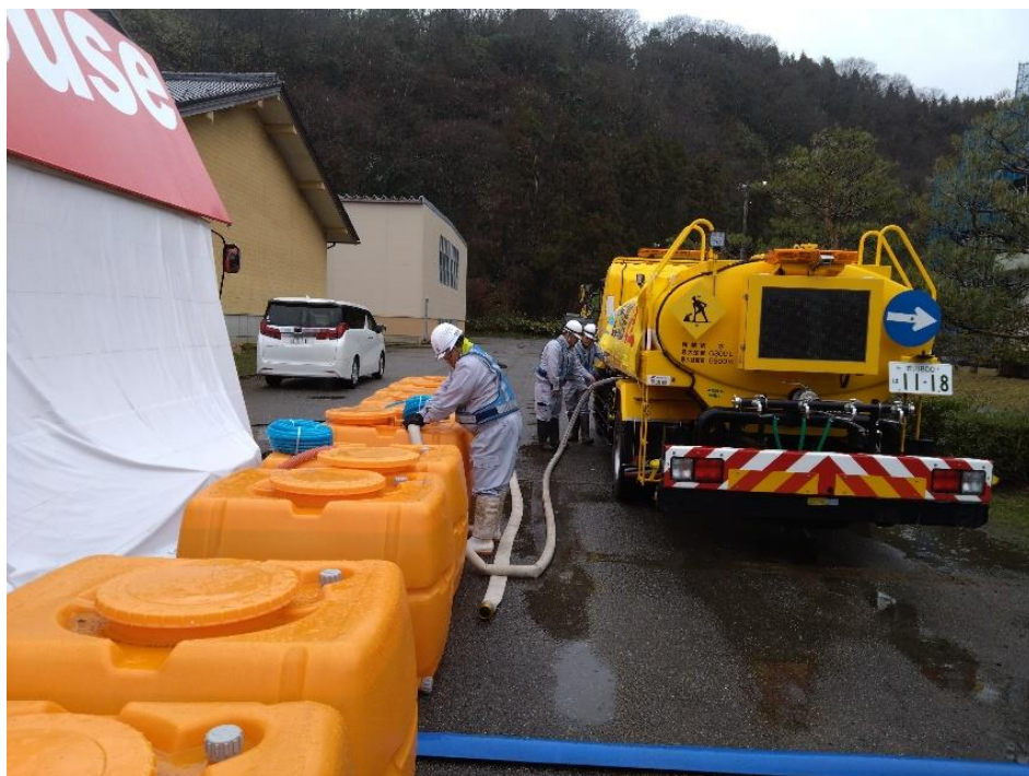
②給水支援班活動状況 (輪島市)
