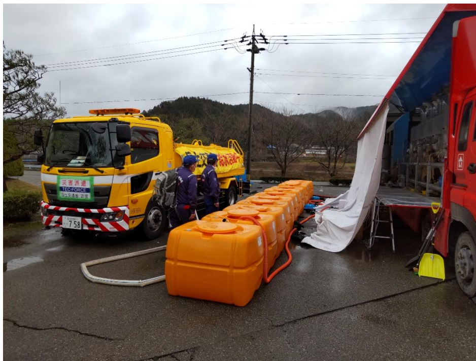
固定給水状況(輪島市門前県民体育館)
