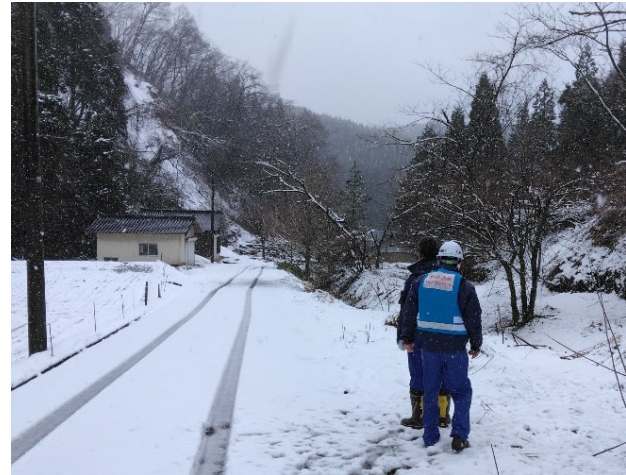
【道路班】輪島市 被災状況調査（22日）
