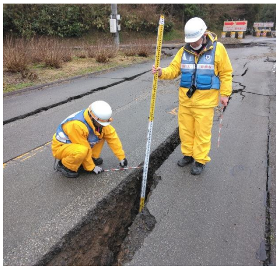
道路47班 調査状況(輪島市門前町二又川)
