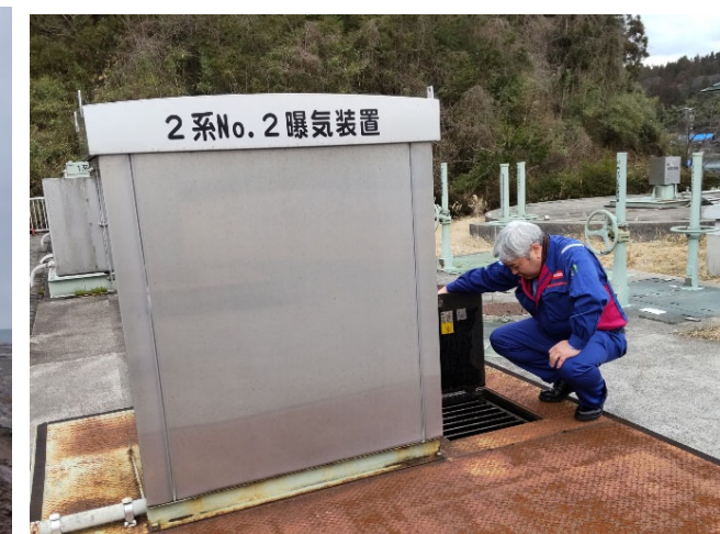
【水道班】穴水町 現地調査（23日）
