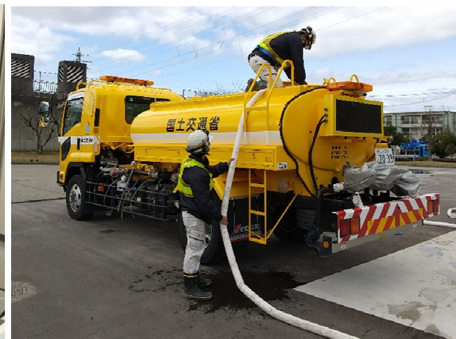
【給水班】金沢市 補水作業（24日）
