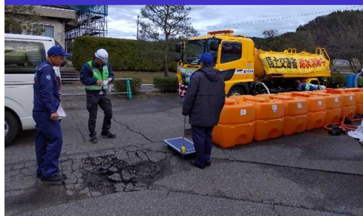
②給水支援班活動状況 (輪島市)
