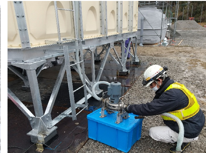
【給水班】珠州市 給水状況（22日）
