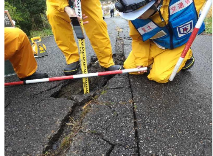
道路班:輪島市で被害状況調査
