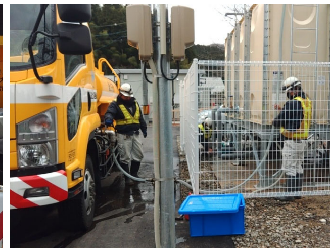
【給水班】輪島市 給水作業（28日）
