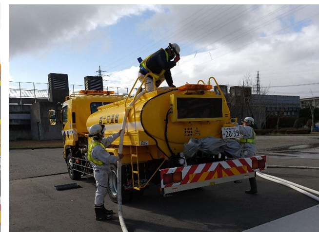
【給水班】金沢市 補水状況（27日）
