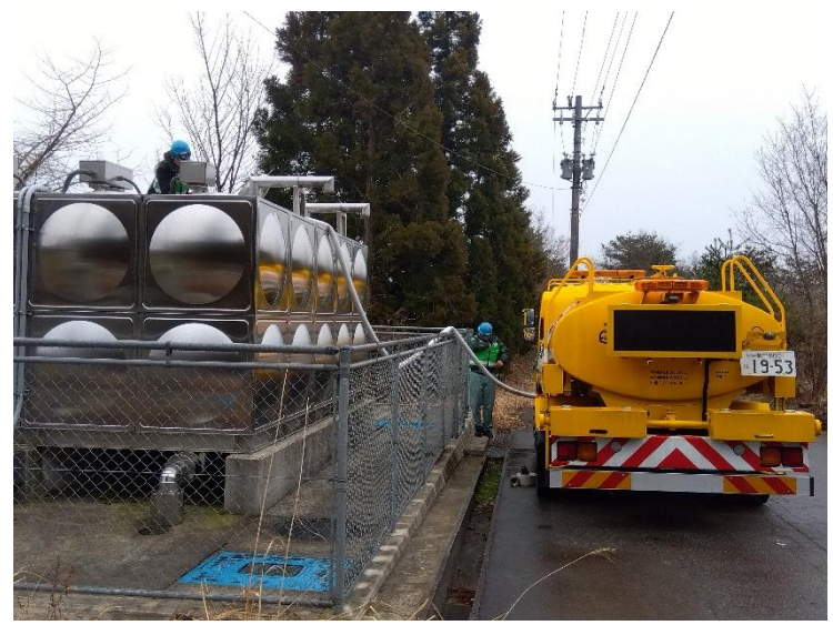
給水状況(能登町内)
