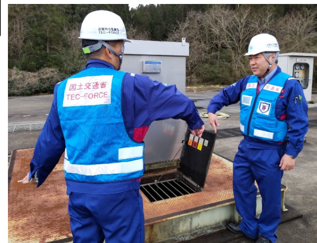
【水道班】金沢市 調査状況（28日）
