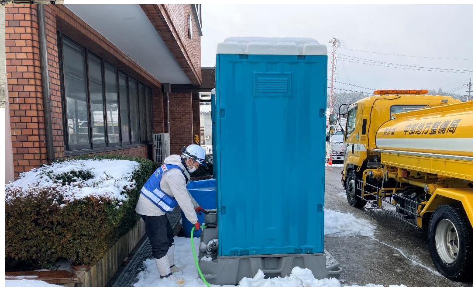
輪島市にて給水支援【応急対策班】
