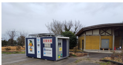
防災用コンテナ型トイレ
