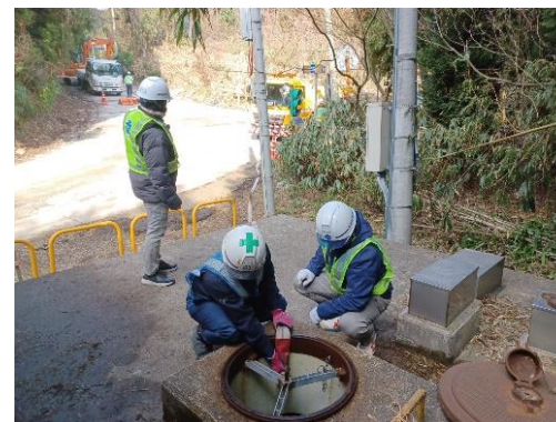
漏水調査のための給水 (輪島市内)
