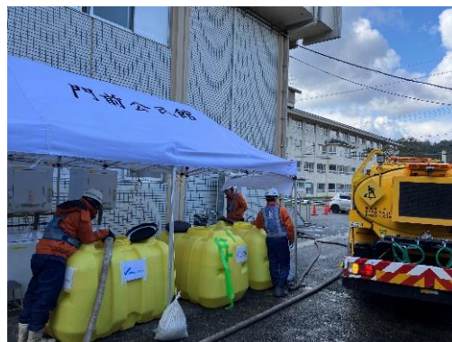
避難所ランドリーへの 給水(輪島市内)
