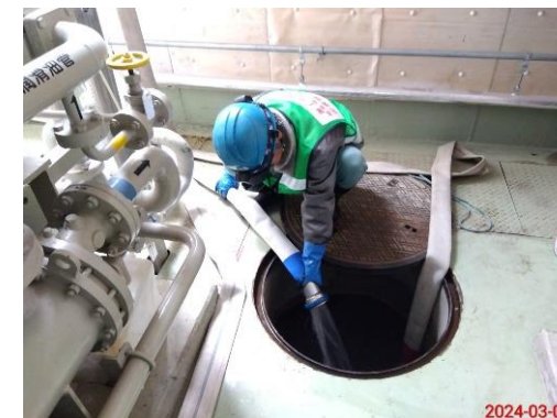
珠洲総合病院への給水 (珠洲市 3/8完了)
