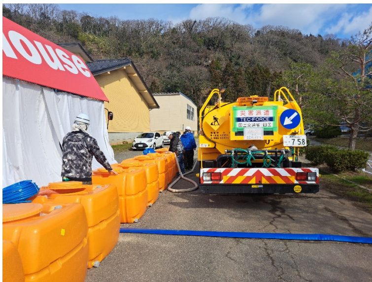
①給水支援班活動状況 (輪島市)
