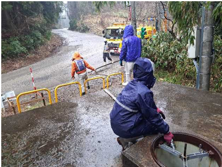
①給水支援班活動状況 (輪島市)
