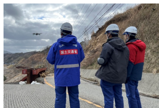
ドローン班 調査状況 (輪島市)
