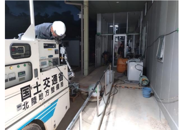
照明車による電源供給作業状況 (珠洲市 大谷小中学校)
